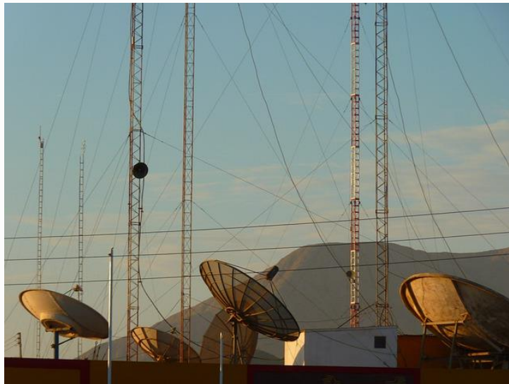
Antenas de radio con vientos para anclarlas al suelo.
